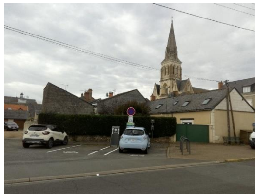
Borne de recharge pour véhicules électriques, Tiercé
