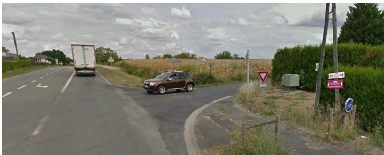
Figure 61 : Carrefour RD 323/RD 109 (ici à droite) vu du sud vers le nord en bordure sud-ouest du site d'extension du PA de la Suzerolle
