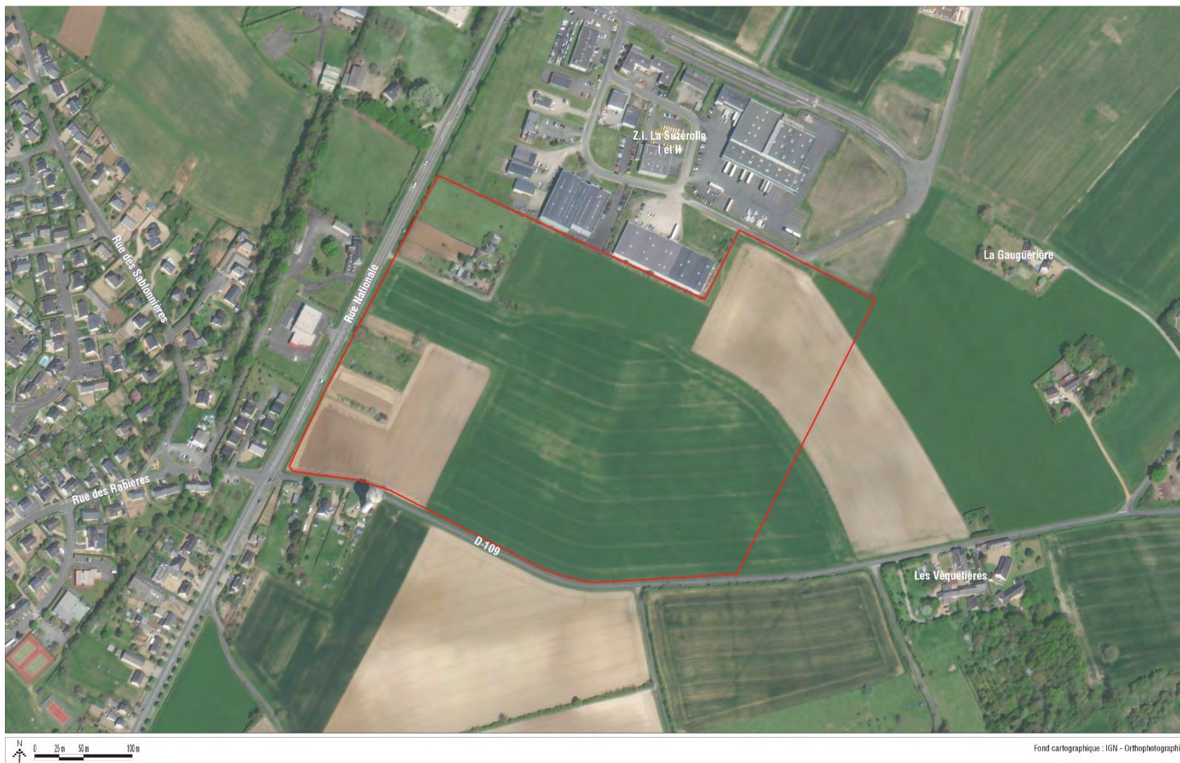
Figure 3 : Vue aérienne du site d'extension du PA de la Suzerolle
