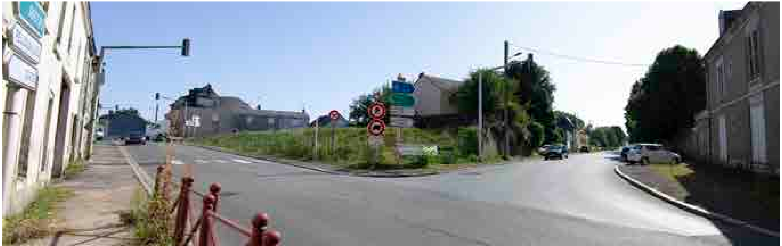
Un carrefour routier à recomposer pour retrouver une articulation urbaine apaisée avec le centre
